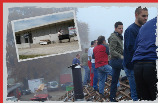
2008-2010 - Sanierung Clubhaus & Bau neue Garderoben
